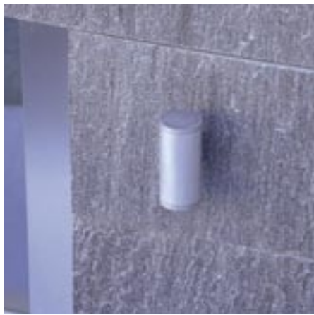
Cette lampe murale, idéalement installée sur la façade, éclaire du HAUT vers le BAS.
